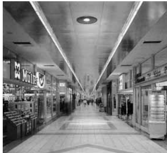
採用新型間接光燈具，利用天花板金屬板擴散反射原理，以創造室內均勻光線。
