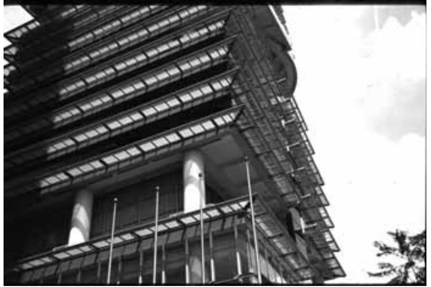
吉隆坡某大樓外遮陽設計
