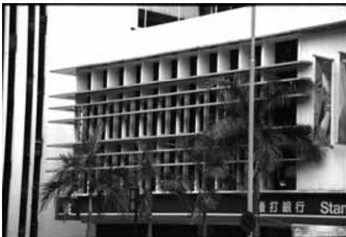
吉隆坡渣打銀行外遮陽設計
