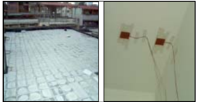
圖 3 屋頂隔熱改善現況及實際量測
