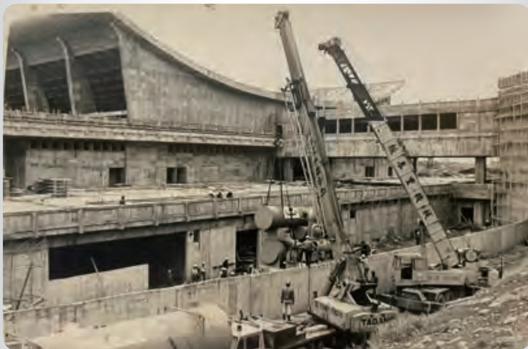
1977年桃園機場一期新建工程，熱回收離心式冰水主機吊裝施工。
