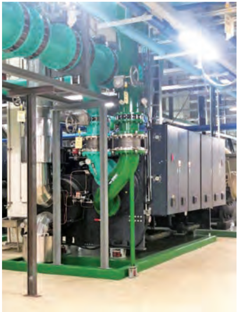
國產1000冷凍噸之無油磁浮離心機，採用漢鐘RTM系列壓縮機，COP可達一級能效（7.1）。
