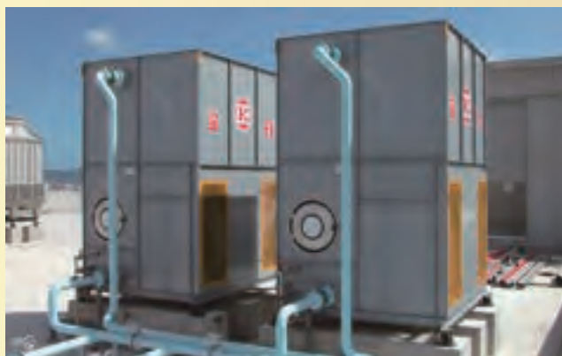
和旭機械以其優異鈹金技術，為冷卻塔打造全鋼外殼，滿足防火要求。
