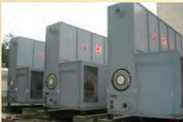
有別於一般冷卻塔，採用和旭機械的離心式送風機，具高機外靜壓的特性。
