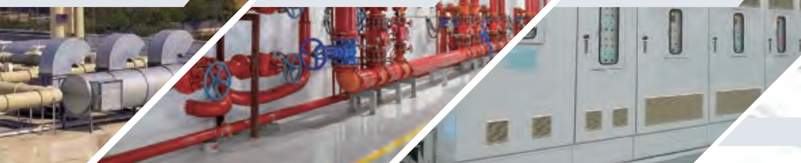
製程廢氣系統安裝工程
