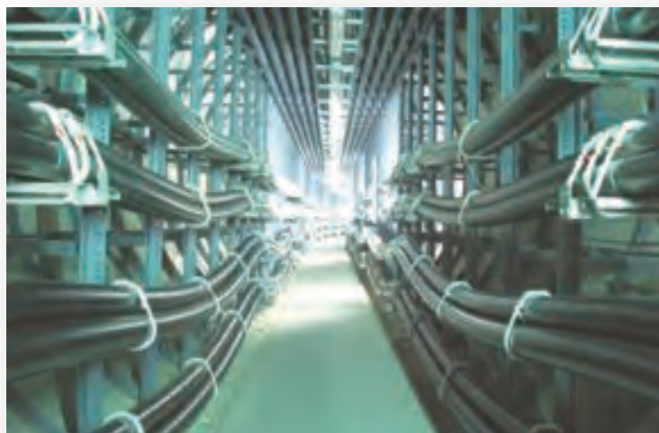
台電高雄345kV高壓電纜洞道冷卻工程
